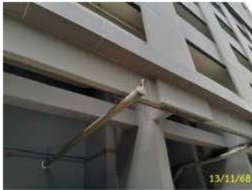
ปล่องระบายอากาศระบบไฟฟ้าสำรอง
