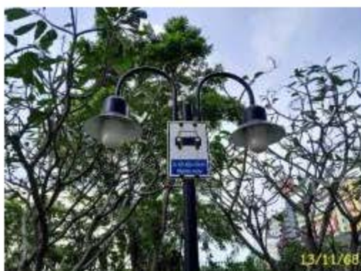
โคมไฟแบบแผ่นสะท้อนแสง
