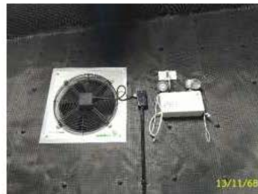
พัดลมระบายอากาศ และไฟฉุกเฉินระบบไฟฟ้าสำรอง
